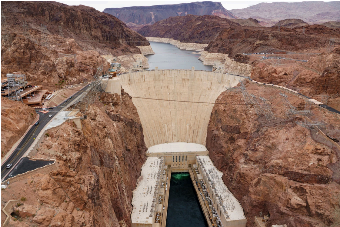
Presa Hoover sobre el río Colorado, en Boulder City, Nevada (EE UU), el 14 de marzo. Kevin Carter (Getty Images)
