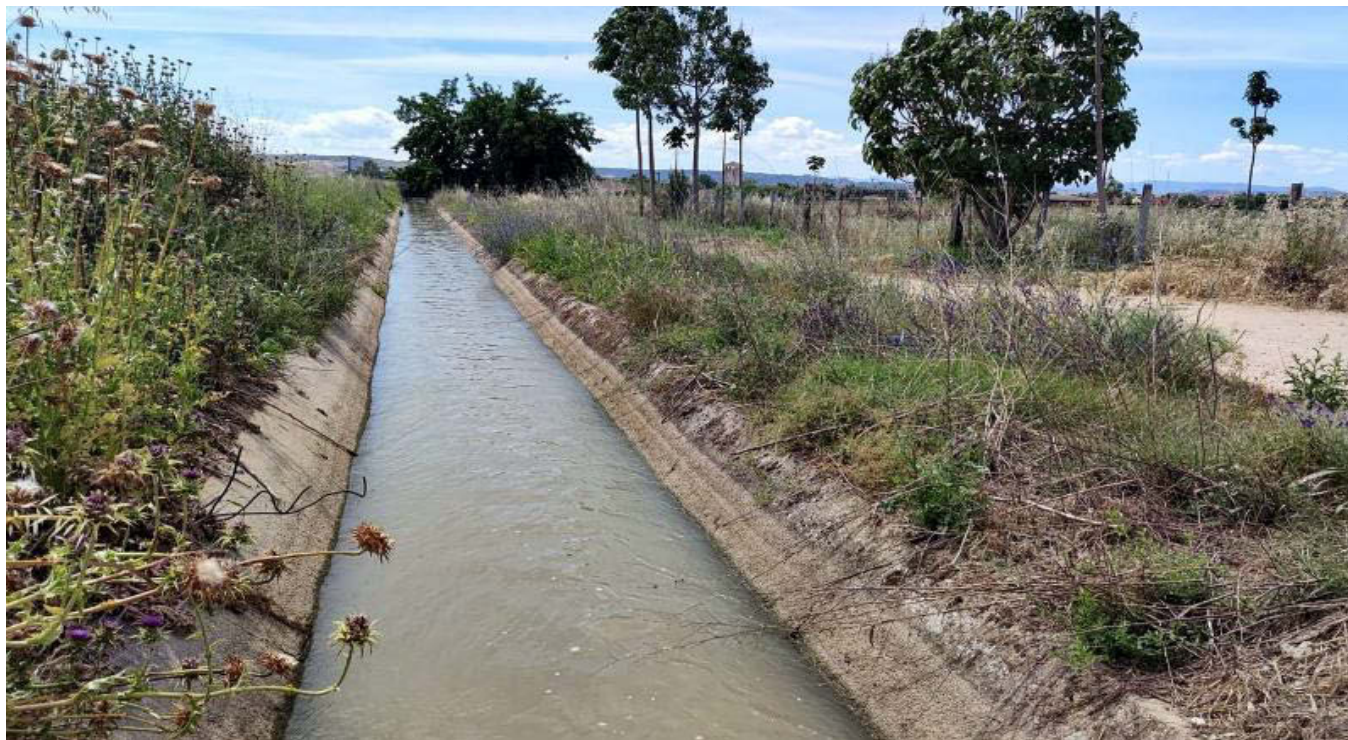
La modernización del sistema de regadío del Canal Bajo del Alberche en un proyecto largamente anhelado por los regantes. / L.G.C.
